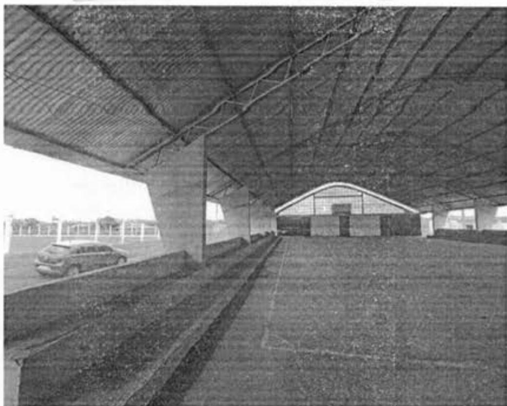
Figura 29 – Quadra – Terças e contraventamentos executados em posição e quantidade adversa Fonte: elaboração própria.
