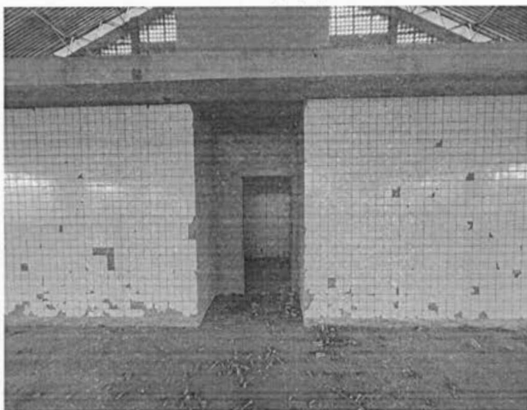
Figura 18 – Vestiário – revestimento cerâmico desgastado
