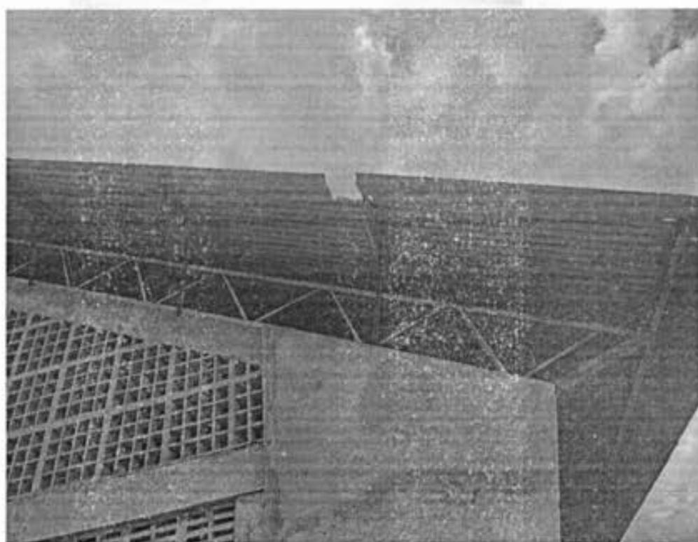
Figura 32 – Quadra - Telhamento com desgastes;
