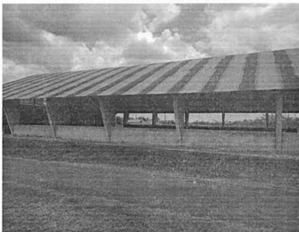
Figura 34 – Quadra – Telhamento apresenta coloração não especificada. Há sinais de oxidação
