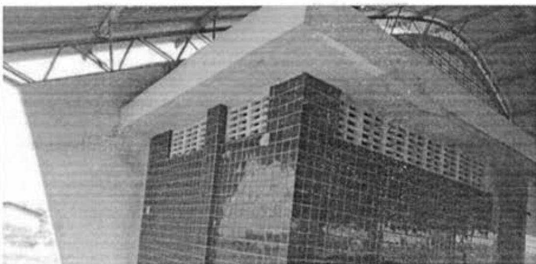
Figura 15 – Vestiário – Presença de infiltração na laje e abertura do quadro de distribuição não executado - Fonte: elaboração própria.
