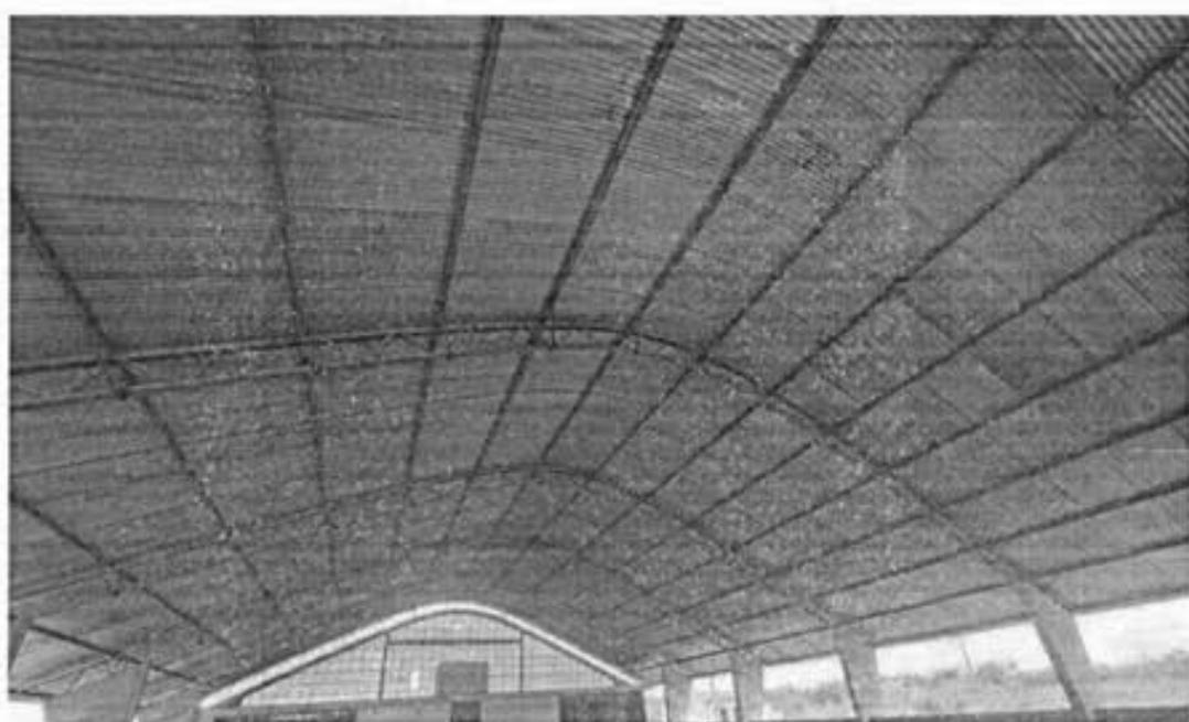
Figura 30 – Quadra – Espaçadores E1 a E4 e E5 e E6 executados em perfis divergentes Fonte: elaboração própria
