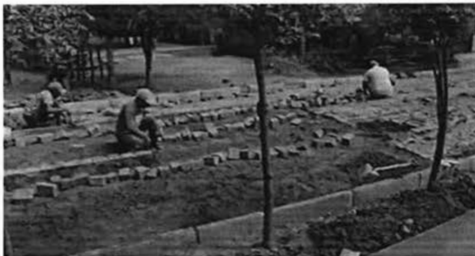
Obra sendo executada
