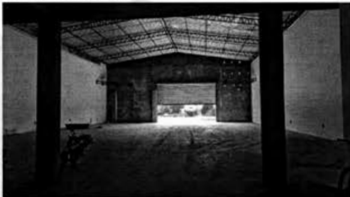
Foto 02 Área interna do Galpão
