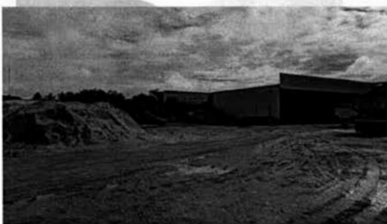
Foto 10 Área externa do Galpão
