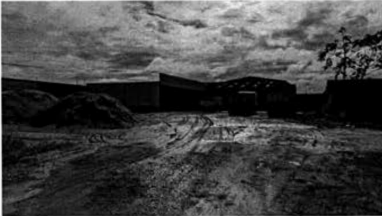
Foto 09 Área externa do Galpão
