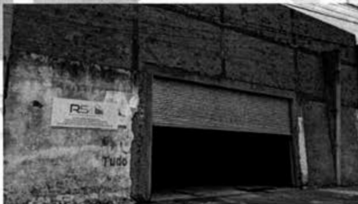
Foto 01 Frente do Galpão
