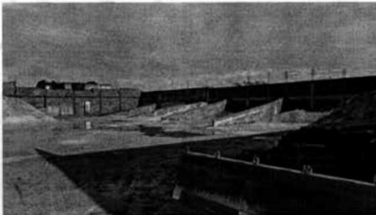
Foto 08 Área externa do Galpão
