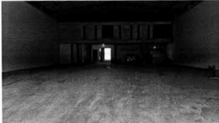
Foto 03 Área interna do Galpão
