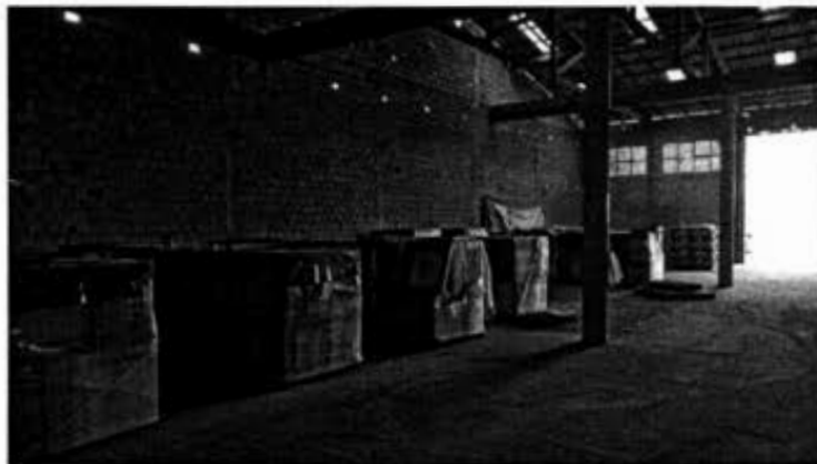
Foto 07 Área interna do galpão
